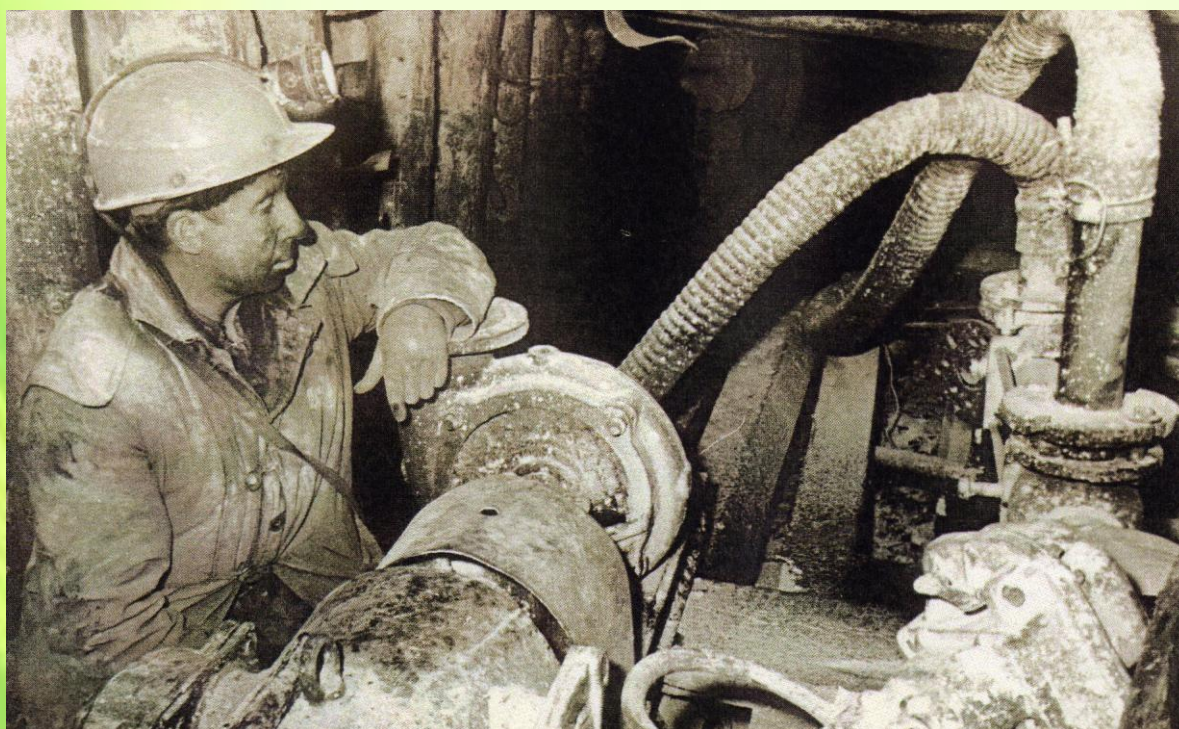
Рабочий участка водоотлива откачивает воду из шахты.
