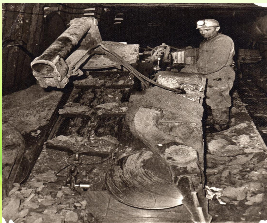
Проходческие бригады нарезают выработки и готовят фронт работы для очистных бригад.
